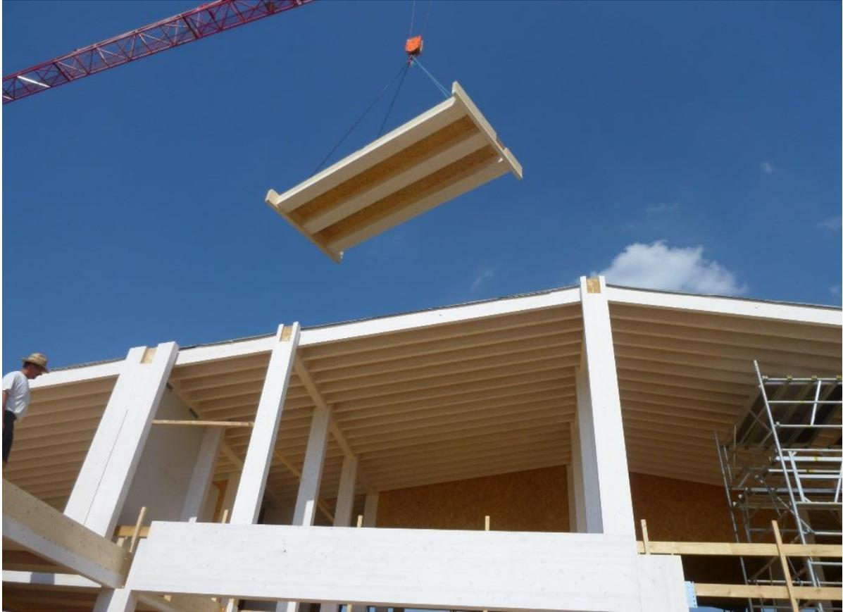
*Abbildung 3.1-10: Einheben Deckenelement Klassenhaus 1*
