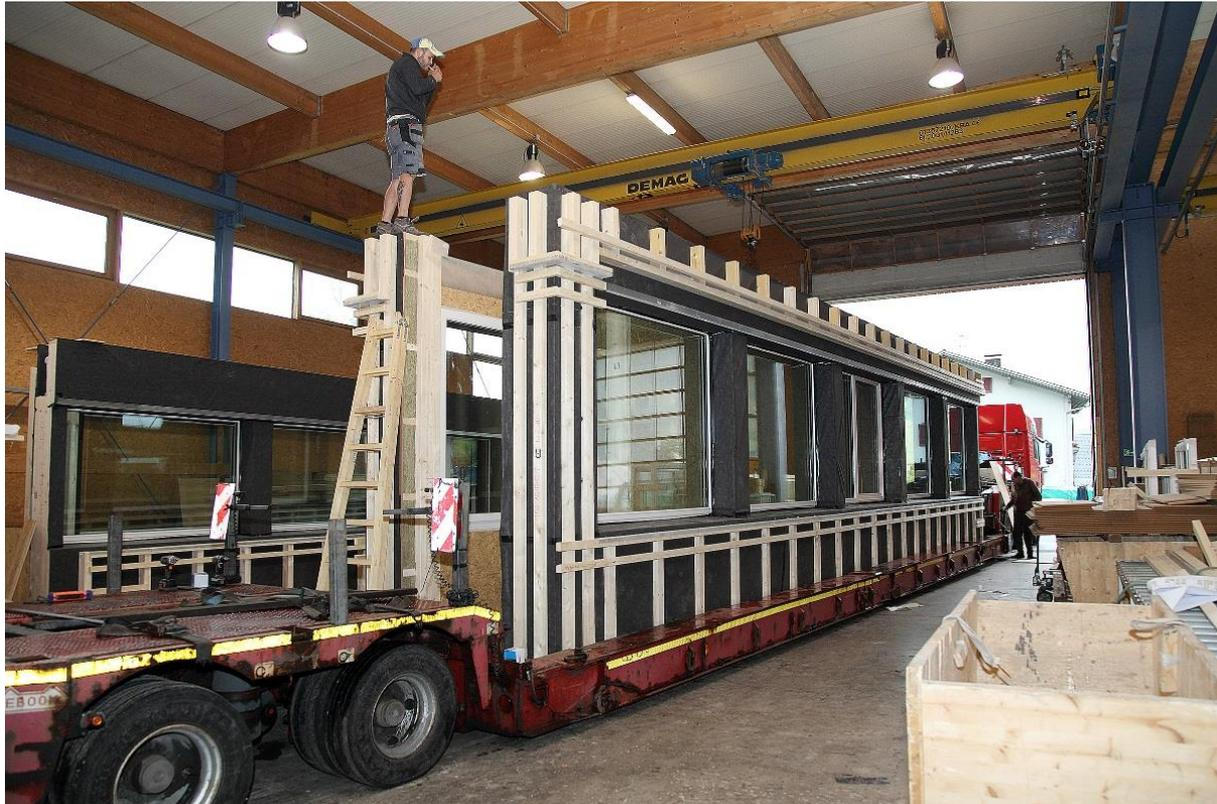
*Abbildung 3.1-12: Verladen und Transport der Wandelemente mit bereits montierten Fenstern Klassenhaus 1,
