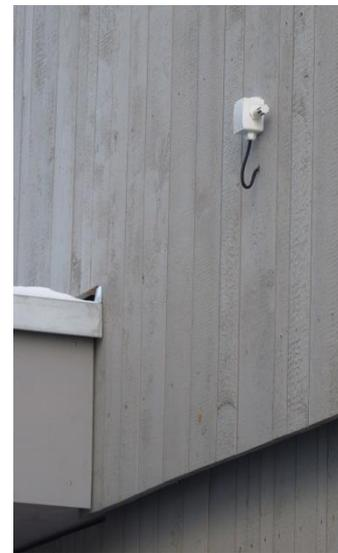
*Abbildung 2.3-29: Außenlufttemperatur und -feuchtefühler Thermokon FTA54VS*
