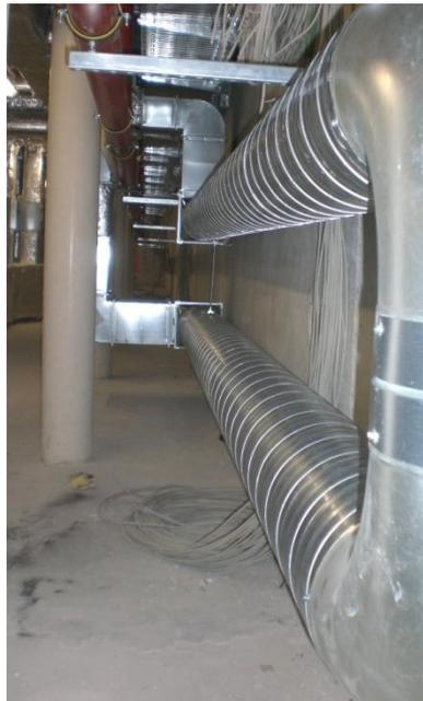
*Abbildung 2.3-31: Messstrecke für die Volumenstromermittlung der Zuluft für die Referenzräume*
