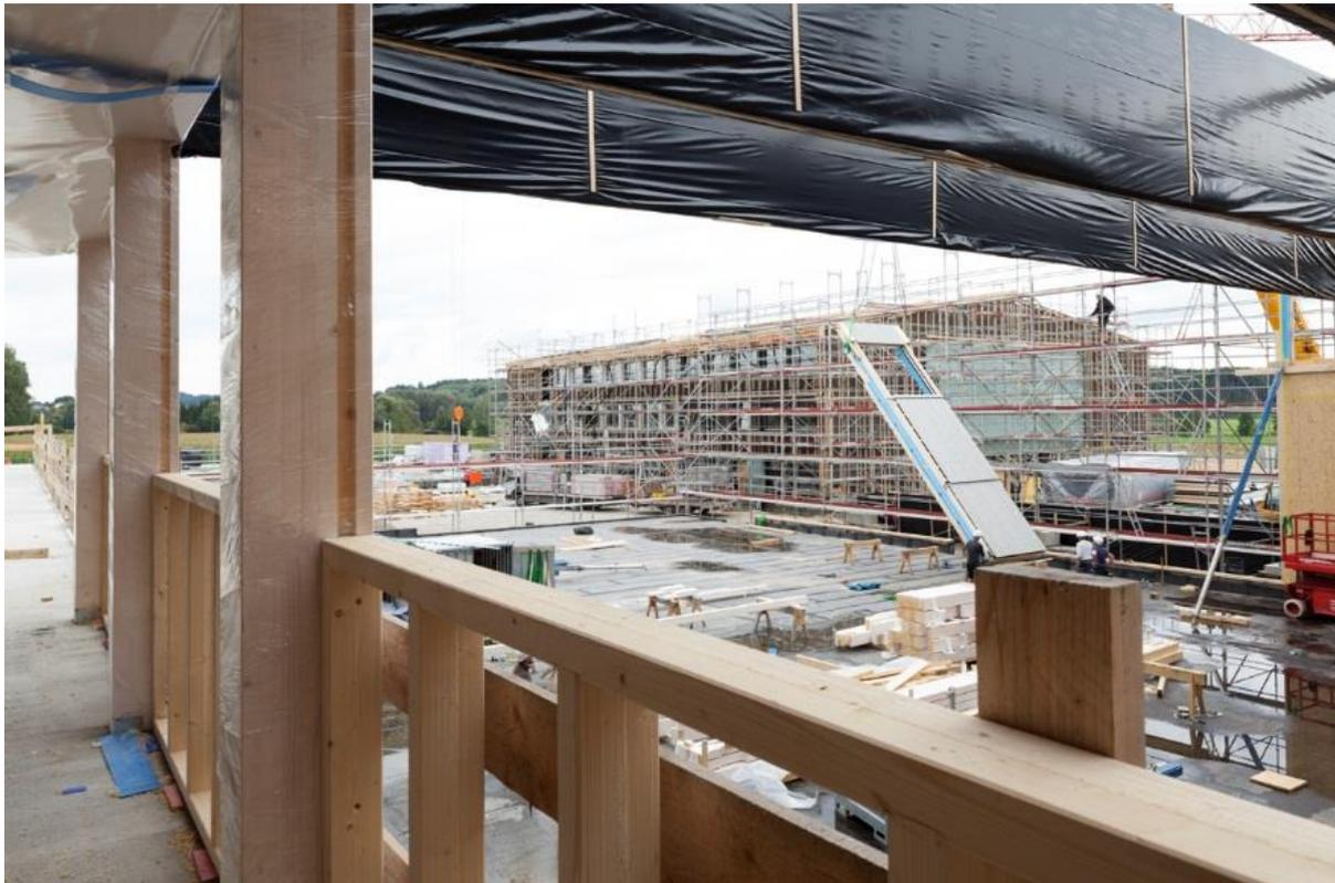
*Abbildung 3.1-15: Versetzen eines vorgefertigten Holzelementes inkl. Fassadenschalung und Schützen der Binder mittels Folie, Foto von Stefan Müller Naumann*
