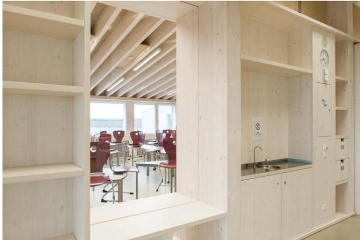
*Abbildung 2.1-15: Mit der Integration von Transparenz, Stauraum und Haustechnik sind die Wände zwischen Klasse und Marktplätzen ein Beispiel für gelungene integrale Planung. (Bild von Fotografin Frau Carolin Hirschfeld)*
