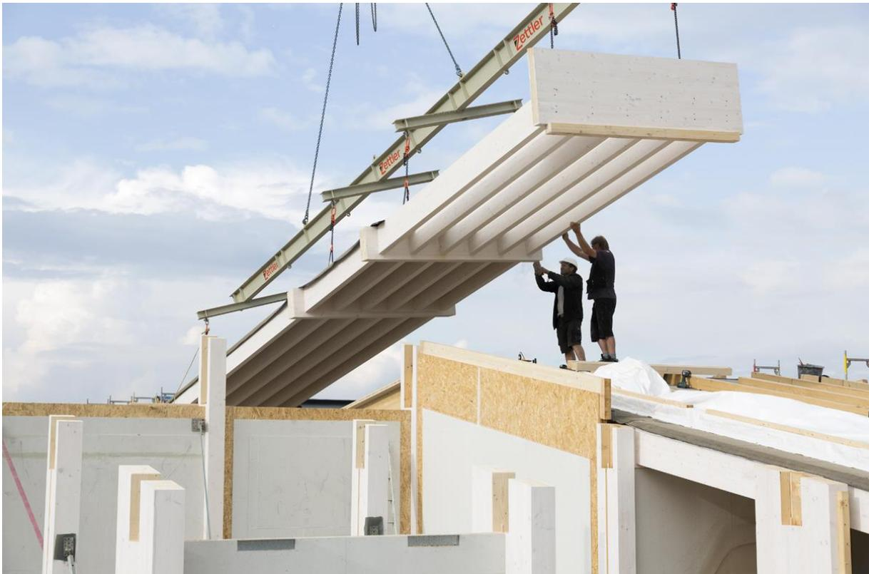
*Abbildung 3.1-11: Einheben Dachelement Klassenhaus 1, Foto von Stefan Müller Naumann*
